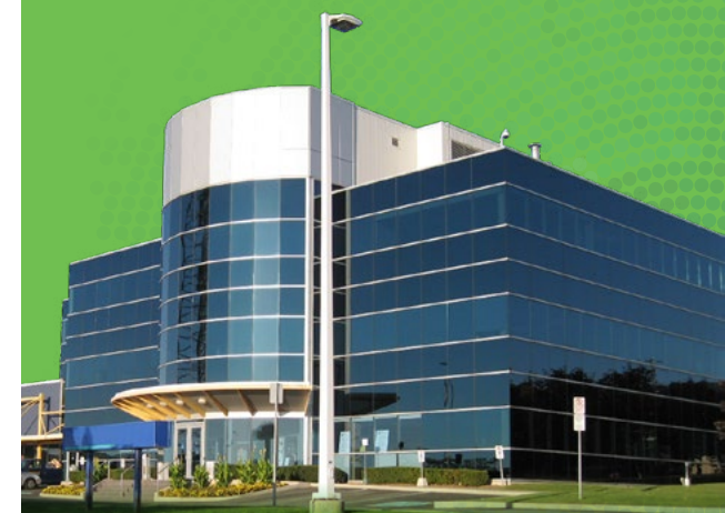
Nos bureaux de Hamilton, de Peterborough et de Burlington ont reçu la certification BOMA BEST, de niveau argent.
